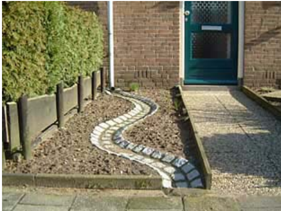
Figuur 6. Aansluiting dakafvoer op straat door middel van goot
