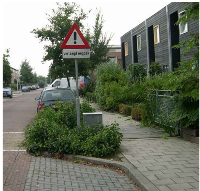
Figuur 9, regenwaterafvoer opgenomen in gevel
