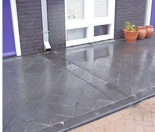
Figuur 7, regenwaterafvoer bovengronds direct aan de straat, afvoer opgenomen in gevel
